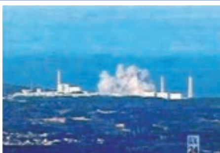
La Centrale Nucleare di Fukushima danneggiata l'11 marzo 2011 dal terremoto.
